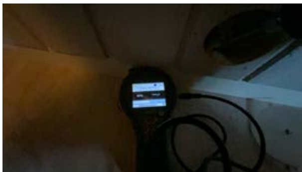
Fuktkontroll med piggmåling viste under 7 vekt%.
