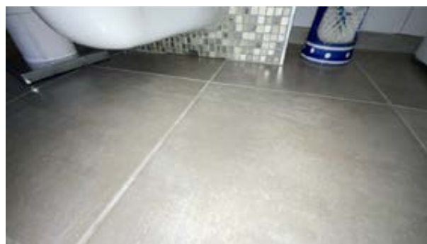
Drensåpning under vegghengt toalett.
