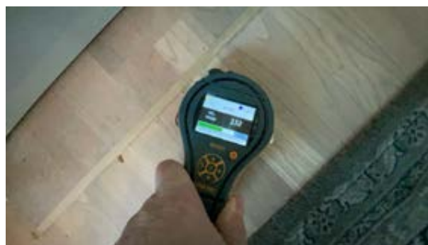
Ikke noe unormale verdier ved fuktsøk nedenfor oppvaskmaskin.
