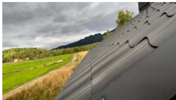
Stålplatetekking. Enkelte synlige rustskader.
