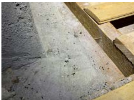
Muselort ved pipe i loft.
