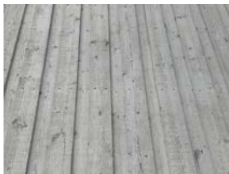
Sprukket kledningsbord vegg mot vest
