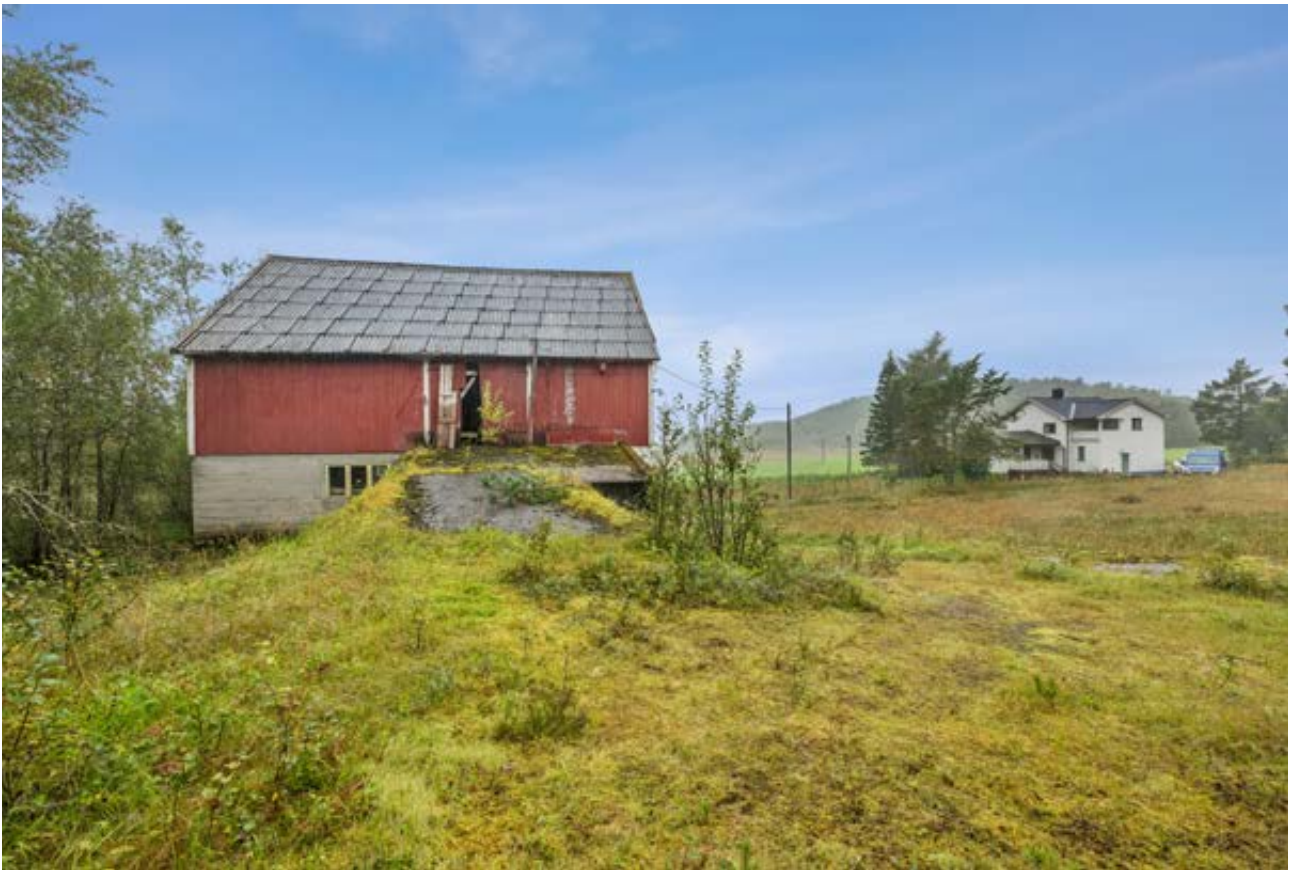
Fjøset i forgrunn, boligen sees til høyre
