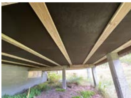
Underside bjelkelag i kryperom.
