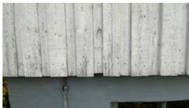
Sprukket kledningsbord vegg mot vest
