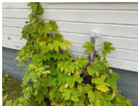
Lufterør/ påfyllingsrør til tank på vegg mot nord.
