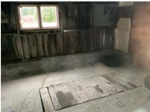
Støpt betonggulv i garasje med luke i gulv for større høyde/smøregrav.
