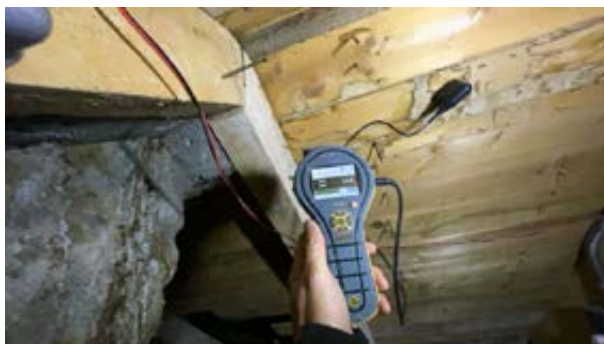
Stikkkontroll av fuktskjold
