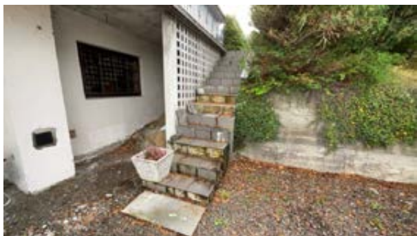
Mangler rekkverk
