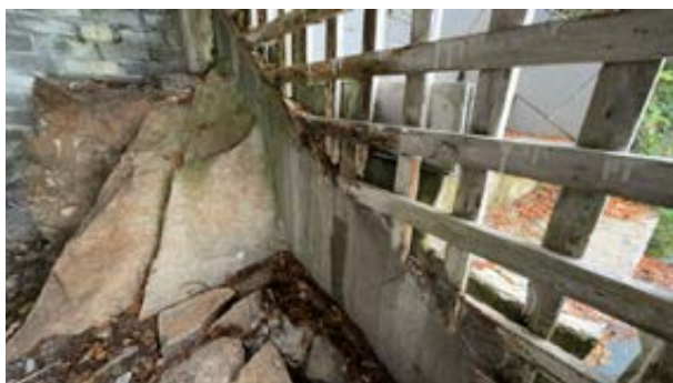
Råteskadet gittervegg.
