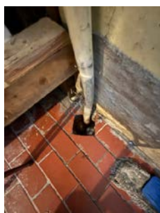
Vaskerom med fliser på gulv og murvegg, sluk fra byggeår
