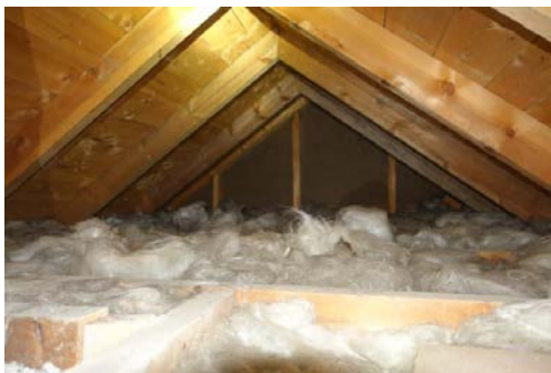
Sperrekonstruksjon/glassullisolasjon
