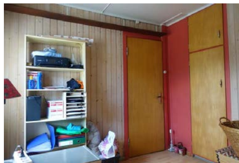
Finert dør på loft
