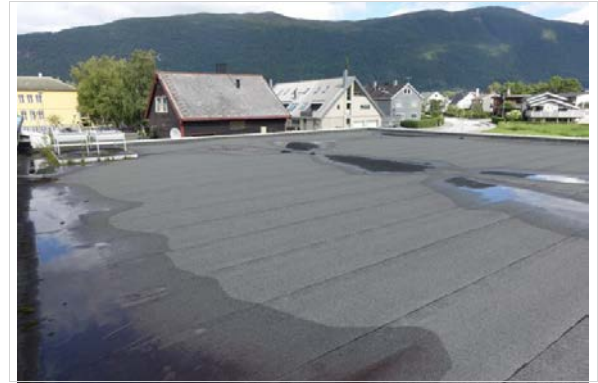
Flatt tak m/innv. nedløp (3 sluker)
