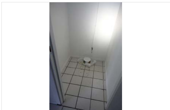
Garderobe-/toalettanlegg er demontert
