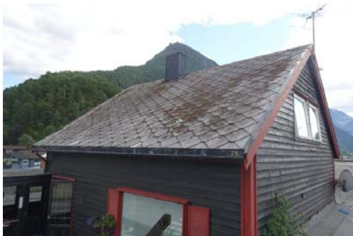
Takflate mot nord
