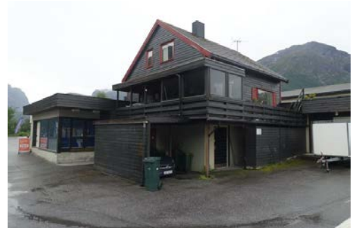
Uteplass mot nord og øst
