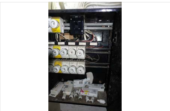
Sikringskap med gamle porselenssikringer
