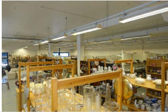
Elementbygg m/søylar, dragere og dekkeelement
