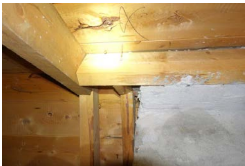
Tørre forhold ved pipegjennomføring
