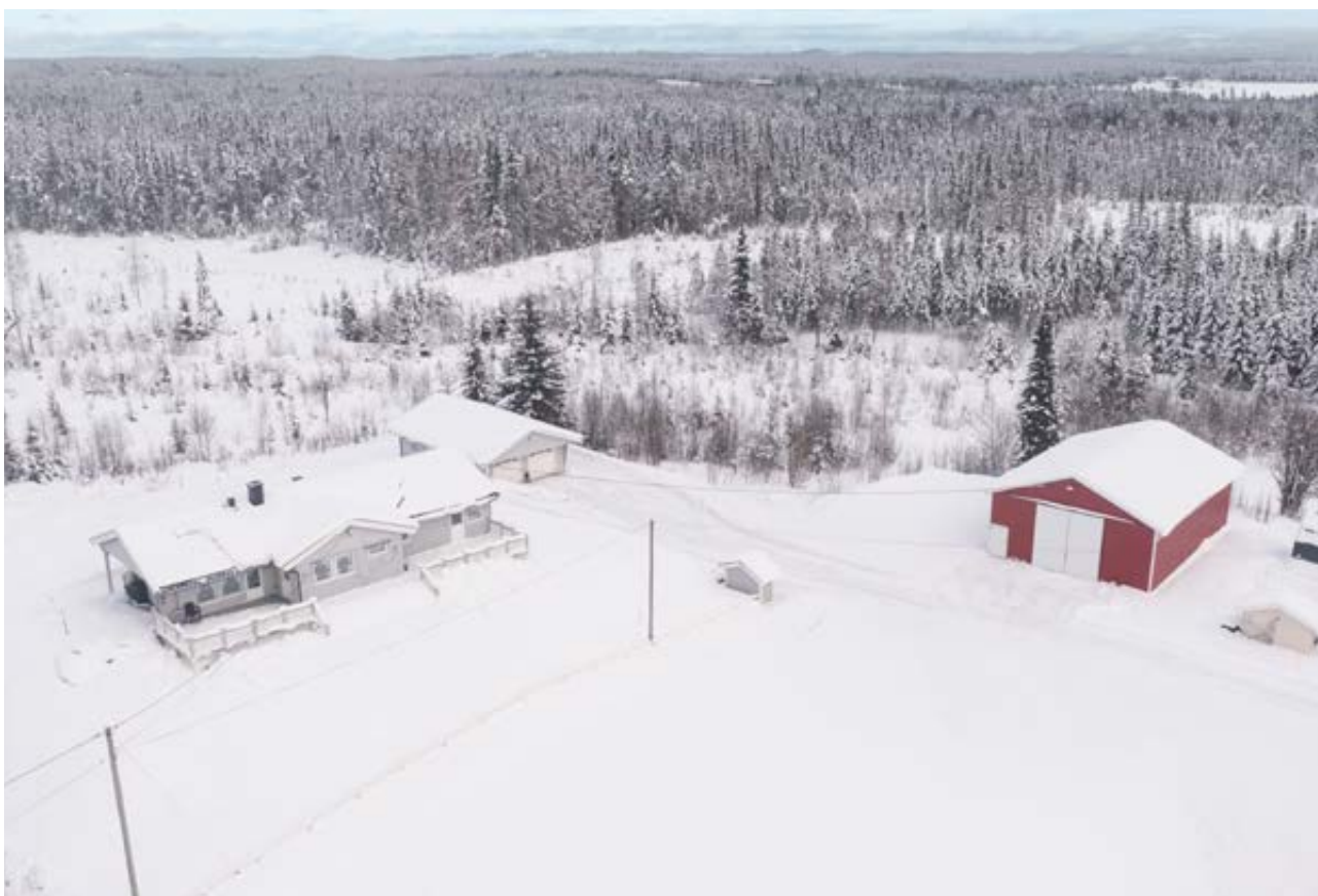
Oversiktsbilde viser husets plassering i forhold til skogen og andre bygninger.
