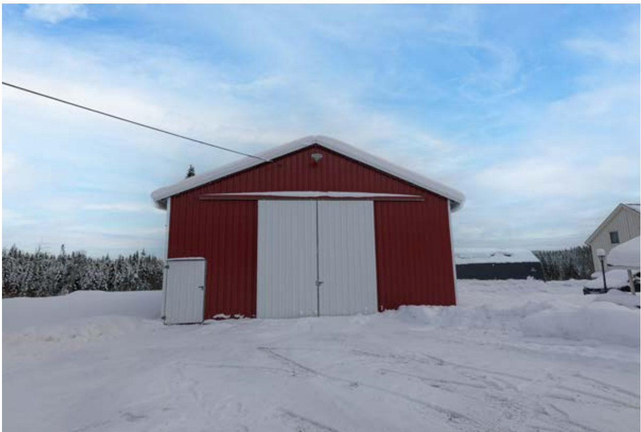
Stålbygg fra 2015 benyttes til oppbevaring av maskiner og utstyr,
