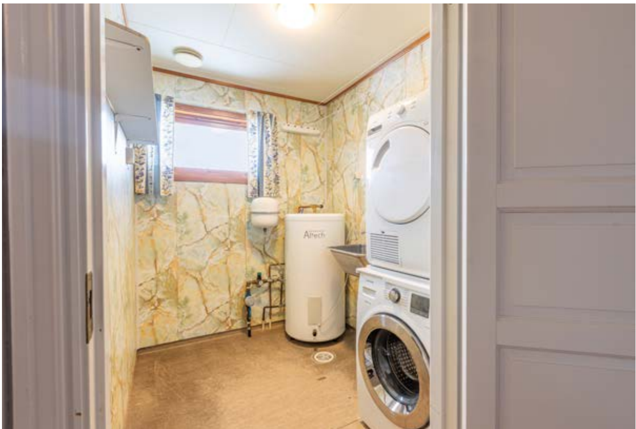
Separat vaskerom er utstyrt med skyllekar og opplegg for vaskemaskin, samt en stråleovn som varmekilde.
