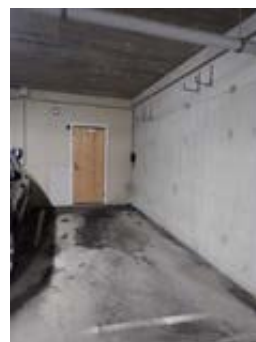
Biloppstillingsplass med el-billader innerst til høyre. 4 kvm stor bod er etablert i bakkant.
