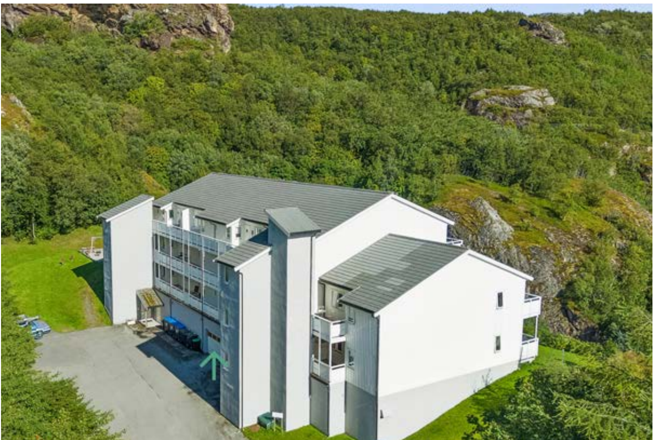
Oversiktsbilde av bygget og med parkeringsplasser - port for innkjøring til garasjen( grønn pil)
