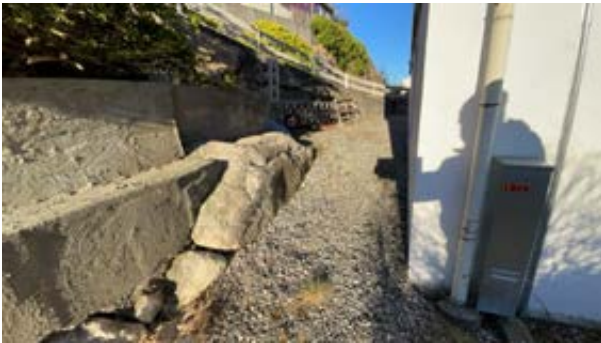
Fall langs bygning mot øst og vest.
