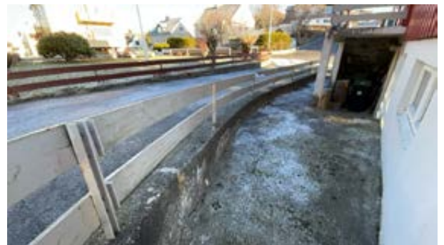
Støttemur mot offentlig vei/gate.
