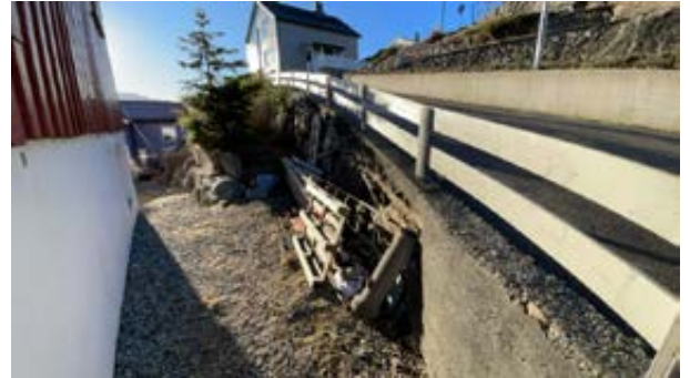
Støttemur mot offentlig vei/gate.
