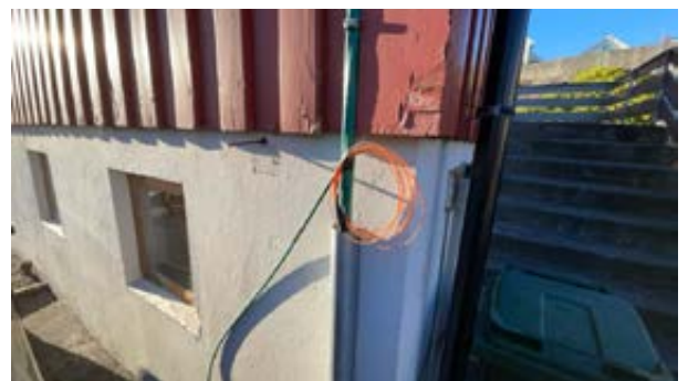
Fiber lagt frem til yttervegg.
