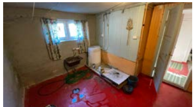
Vaskerom i sokkeletasje
