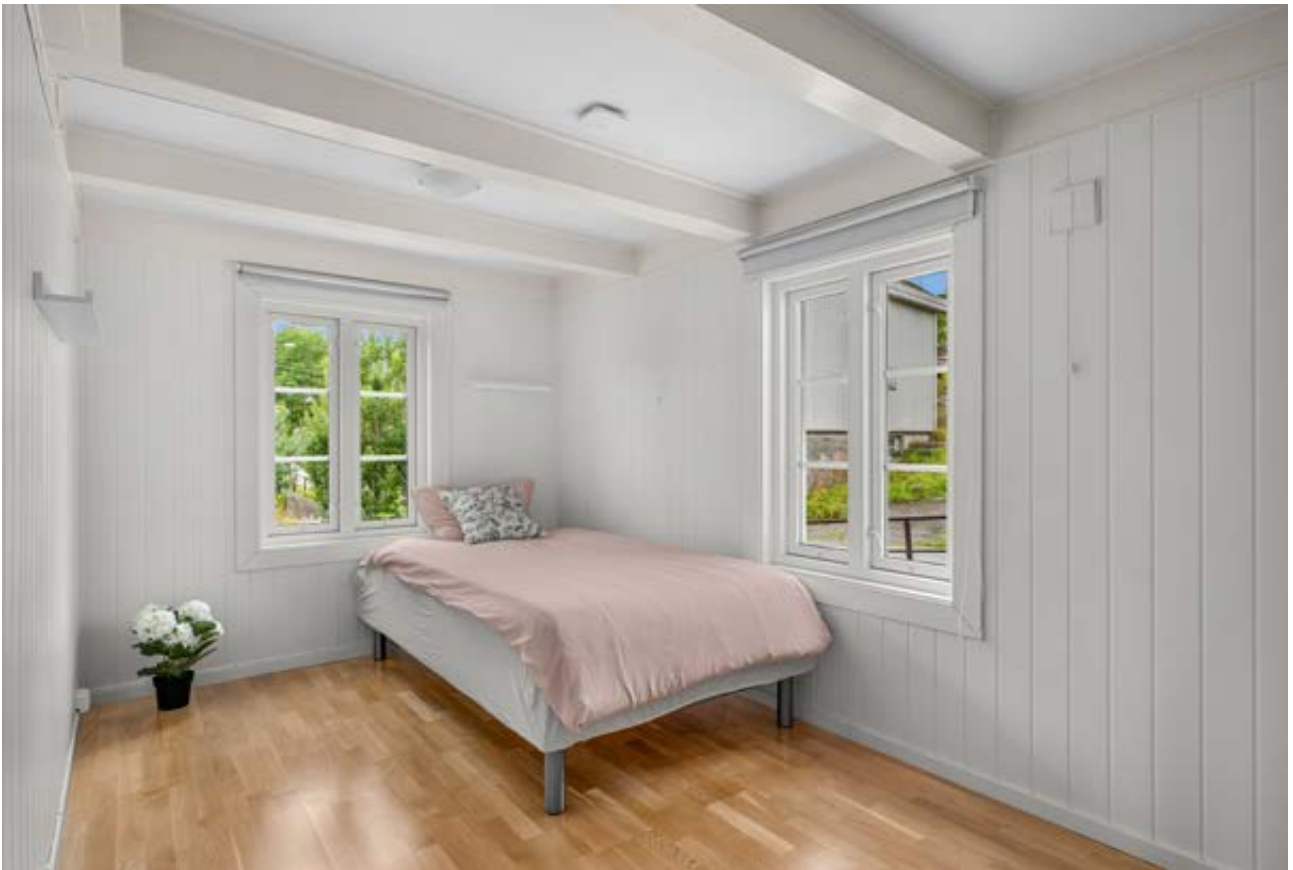
Soverom (vinduet er for lite for å regnes som rømningsvei)
