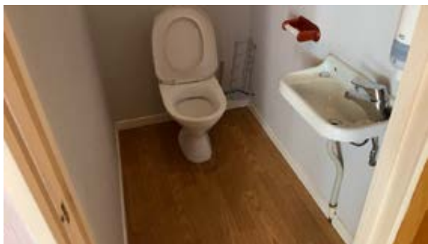
Toalettrom i hovedetasje
