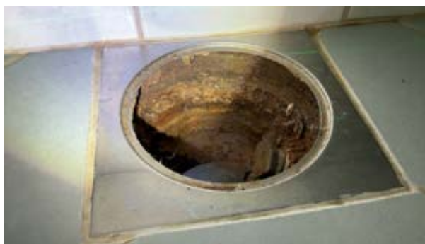
Støpejernssluk under innredning
