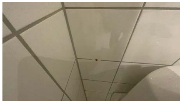
Skruer hull bør tettes.
