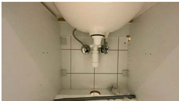
Besiktigelse av røropplegg.
