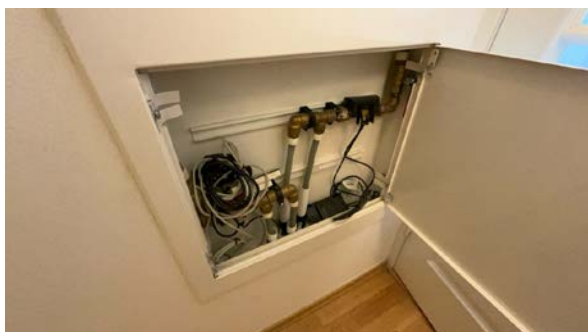
Besiktigelse av røropplegg.
