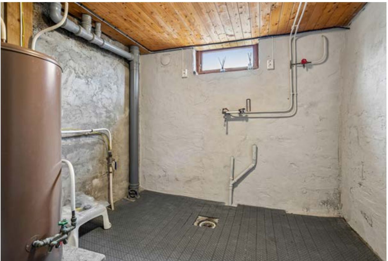
Vaskerom i kjeller
