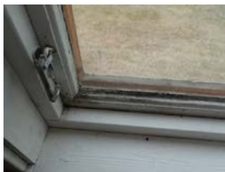
Råteskadet vindu
