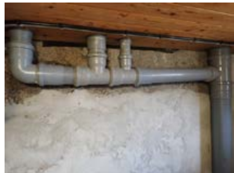
Plast avløpsrør
