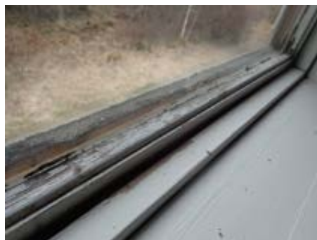
Råteskadet vindu
