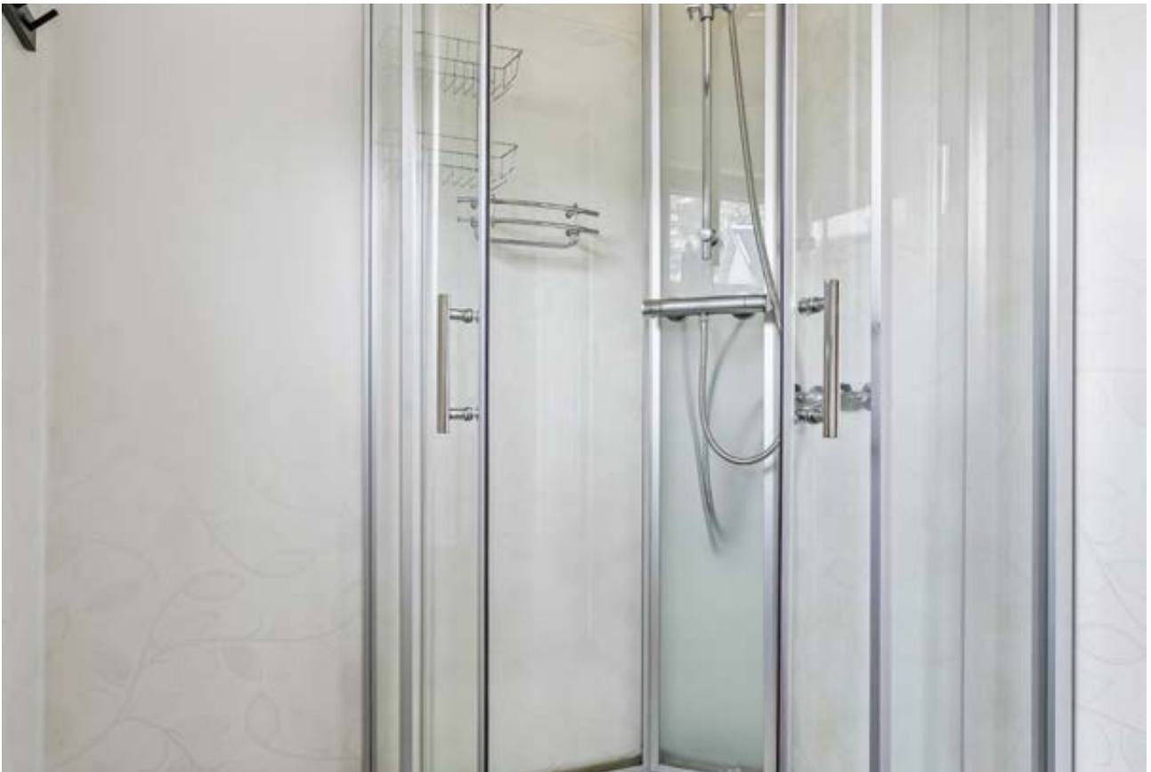
Baderom med dusjkabinett
