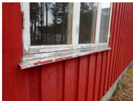
Råteskadet vindu
