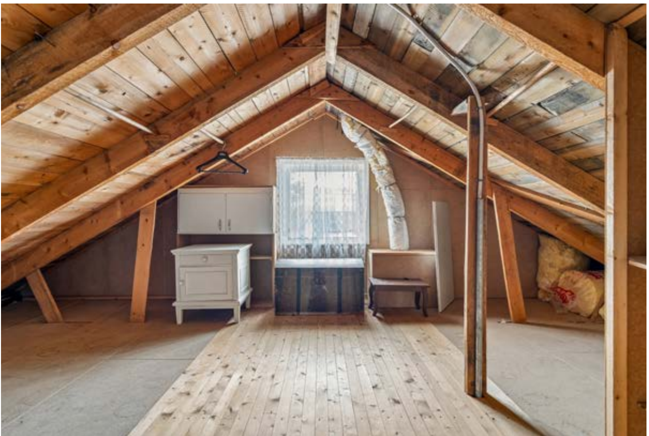
Del av uisolert rom på loft
