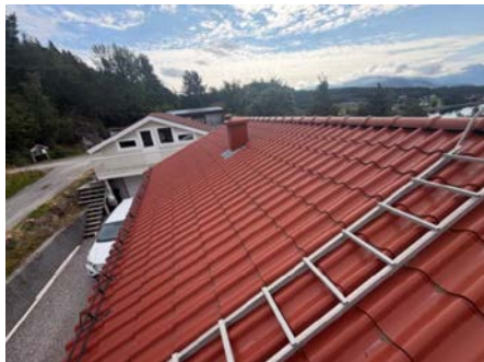
Oversiktsbilde av takteking.
