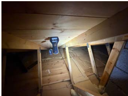
Fuktmåling, ikke utslag på fukt.
