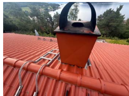
Skorstein over tak.
