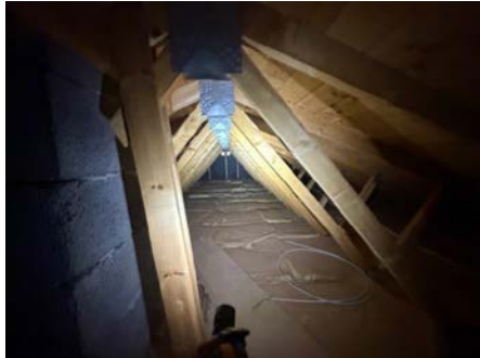
Oversiktsbilde av kaldloftet.
