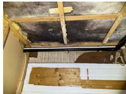
Kjeller, under inngang 1.etasje
