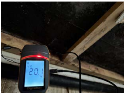
Kjeller, under inngang 1.etasje
