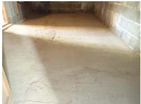
Grovstøpt betonggulv
