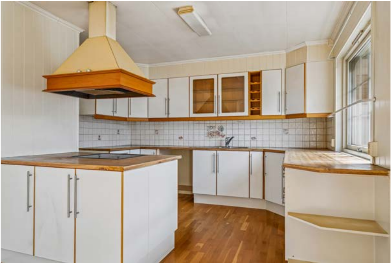
inn til kjøkkendelen - Ventilator type Rørshetta
