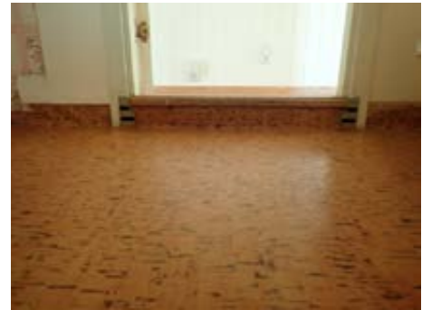
Oppbrett ved dør.
