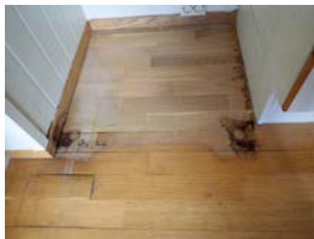
Fuktskader i gulv ved kjøleskap
