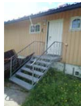
Strekkmetalltrapp foran hovedinngang
