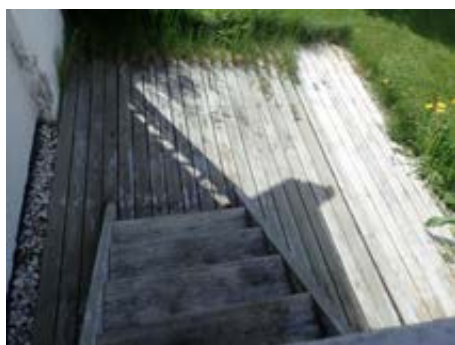
Trapp fra terrasse dekke til altan
