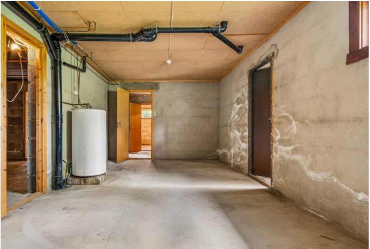
Kjellerrom hvor varmtvannsberederen er plassert
