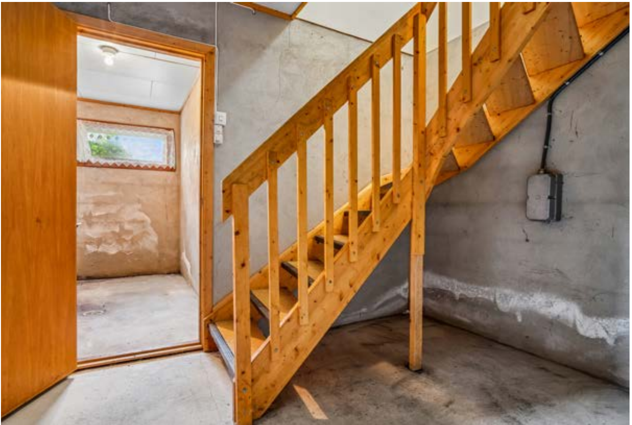
Kjeller med trapp fra hovedetasjen
