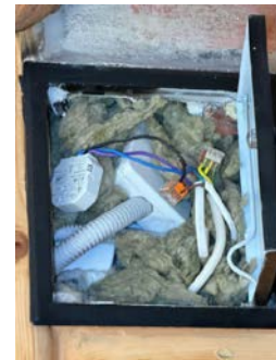
Luke over kjøkkenbenk med div. elektrisk. (
