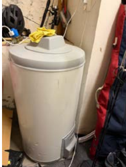
Bereder i kjellerbod med Waterguard/vannsikring
