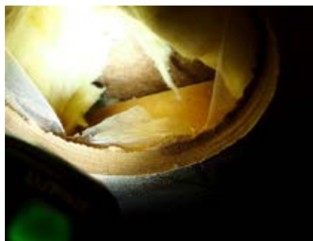
Ingen synlig fukt
