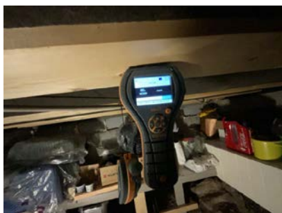
Fuktmåling i treverk
