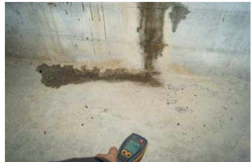
Det er påvist fuktgjennomtrenging inn i kjellermur.
