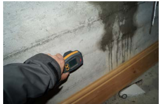
Det er påvist fuktgjennomtrenging inn i kjellermur.
