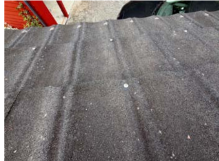
Takteking over utvendig inngangsparti.
