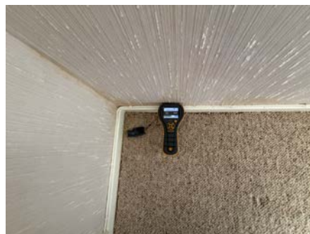
Fuktmåling med pigger i vegger mot sørvest. Ikke utslag på fukt.
