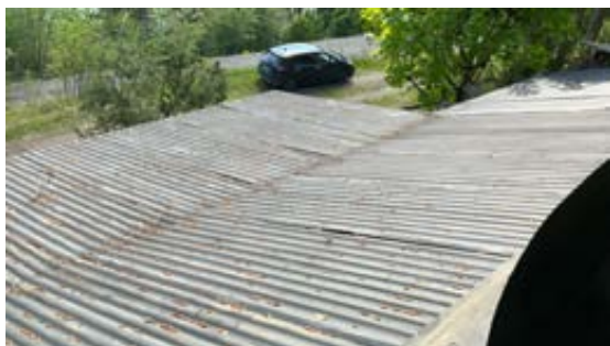
Besiktigelse av tak, malingsflask og enkelte løse spiker.
