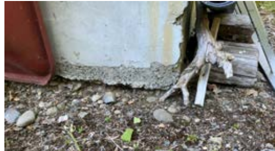
Forenklet og grunn fundamentering i forbindelse med ringmur.
