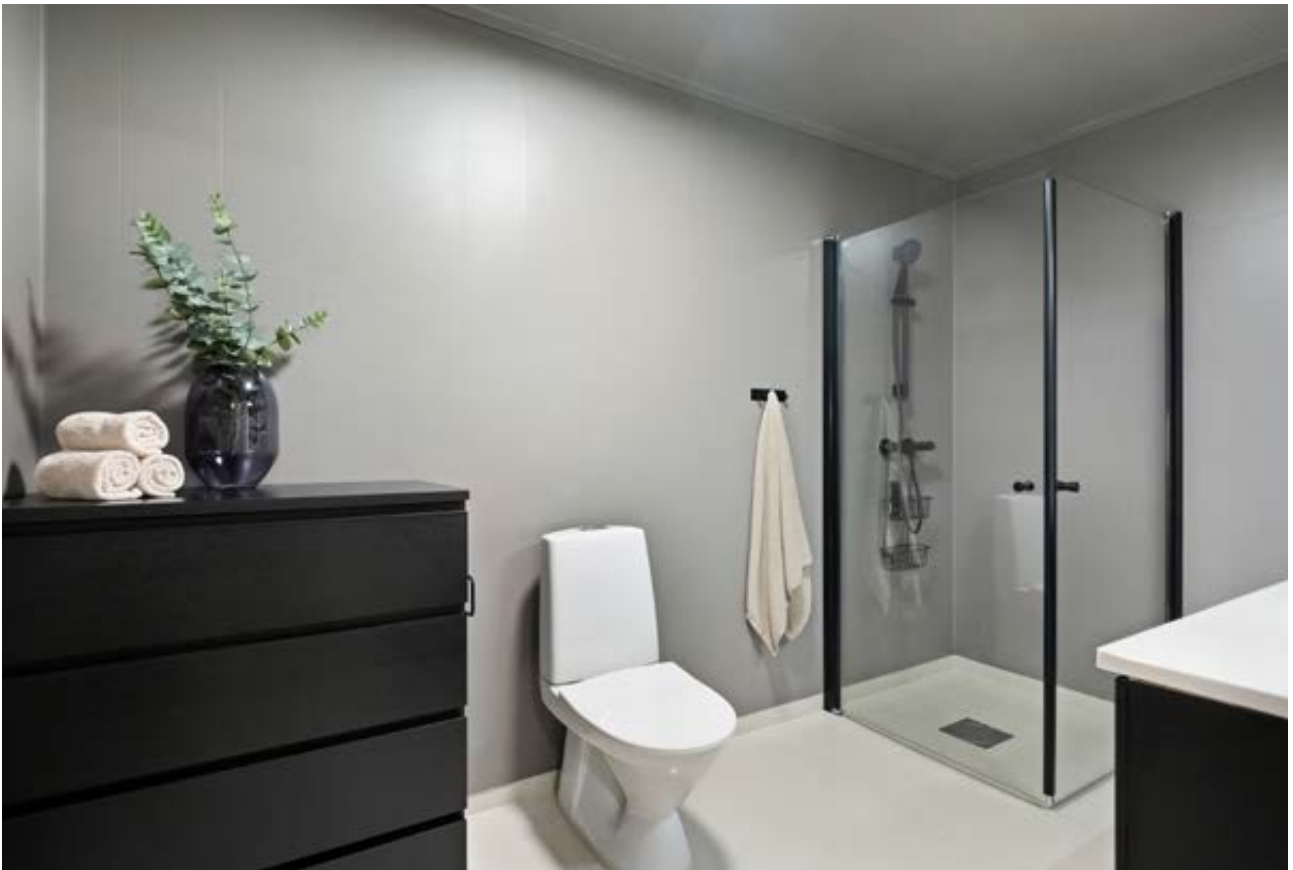
Bad med malte fliser og varmekabler i gulv, malte våtromsplater på vegger
