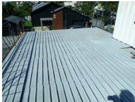
Takterrasse med treplattung
