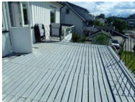
Takterrasse med treplattung
