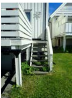
Betongtrapp i terreng for adkomst kjeller.
