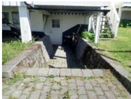
Forstøtningsmurer ved kjellerinngang.
