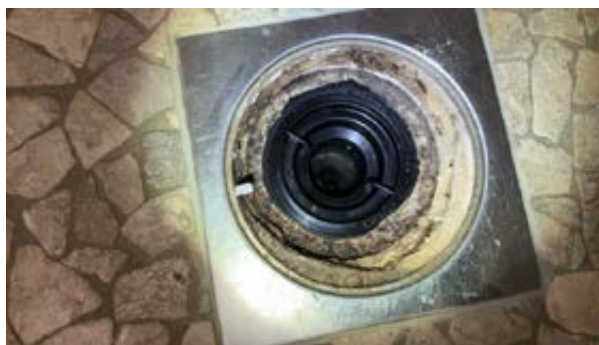
Sluk bad i 1.etasje
