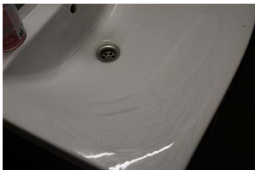
Det er påvist riss/krakelering i servant
