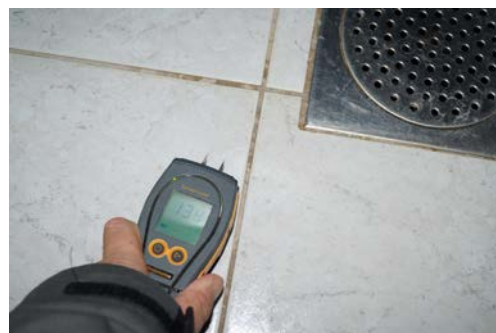
Indikasjonsmålinger er foretatt i de relevante våtsoner ved befarig, uten at det ble påvist indikasjoner på fuktskader.
