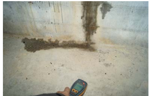
Det er påvist fuktgjennomtrenging inn i kjellermur.
