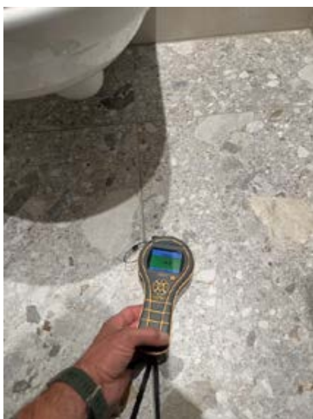
Ingen indikasjon på fukt
