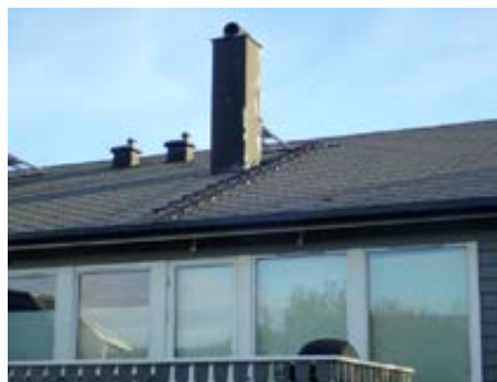
Heldekkende pipebeslag
