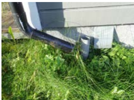
Ikke tilkoblet drenering.
