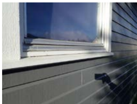
Vindu type Nordan - innad slående med 3-veis lukke/åpne funksjon
