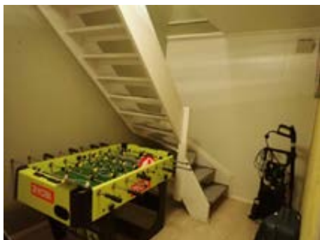
Kjellertrapp uten rekkverk.
