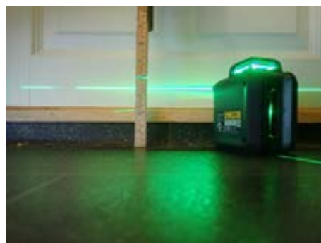
Oppbrett ved dørstokk på 35 mm
