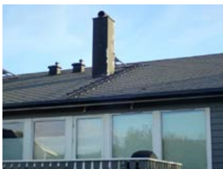
Heldekkende pipebeslag med integrert stigetrinn og plattform
