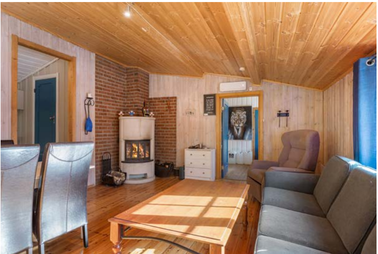
Innvendige overflater består av laminat og furugulv, med ubehandlet eller malt panel på veggene og i taket.
