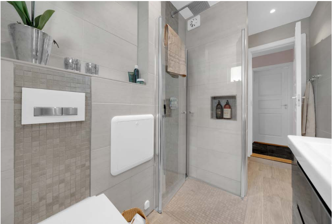
Dusjsonen har en slukrenne ved veggen og avtrekksventilasjon.
