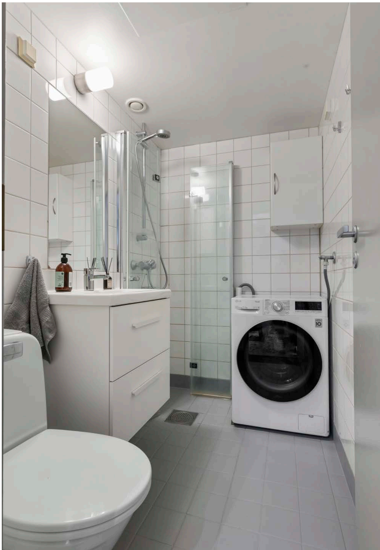
Malt flislagt gulv med vannbåren varme.
