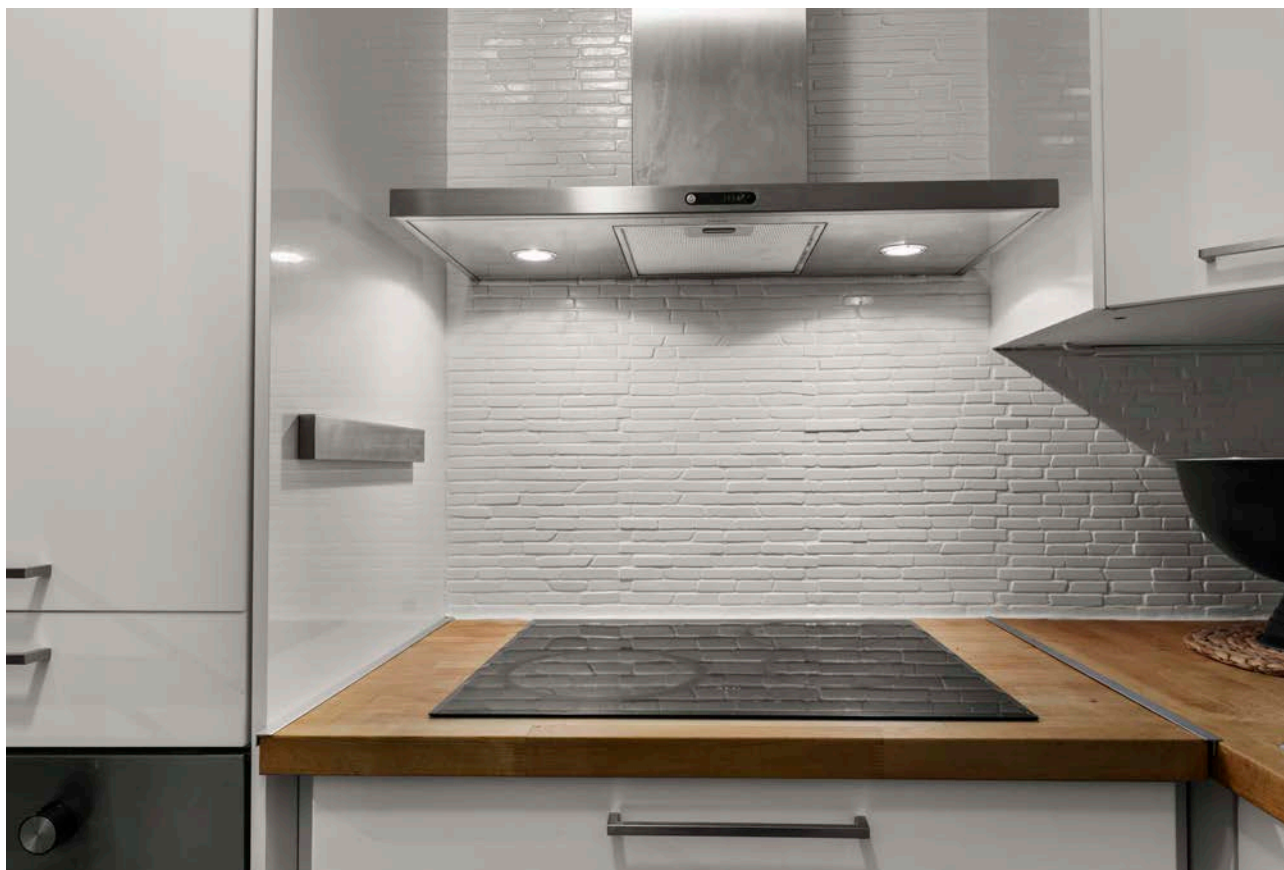
Keramisk platetopp fra 2022. Ventilatorvifte via sentralt avtrekksanlegg i bygget.
