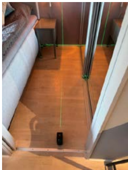
Foto viser nivellering med krysslaser i soverom
