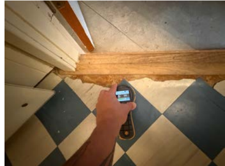
Ikke utslag på fukt i gulvet ved døren.
