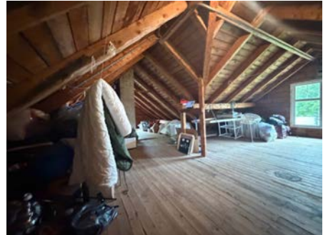
Oversiktsbilde av loft i hovedhuset.
