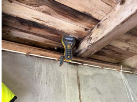
Fuktmåling, ikke utslag på fukt.
