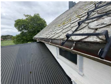
Oversiktsbilde. En del bulker på takteking over inngangsparti.
