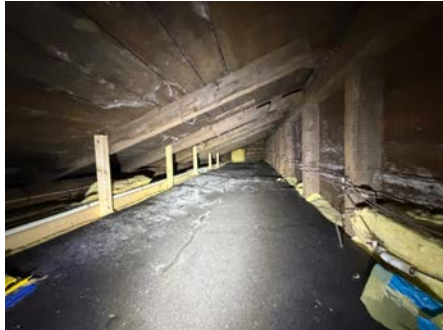
Oversiktsbilde over loftet i vestfløyen.
