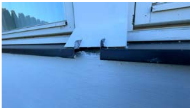
Mindre god og dels utett løsning ned mot vannbrett
