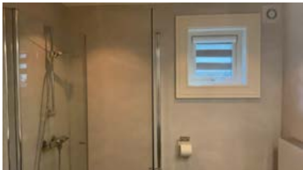
Vindu i våtzone
