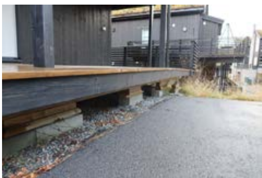
Synlig fall mot ytterhjørne.
