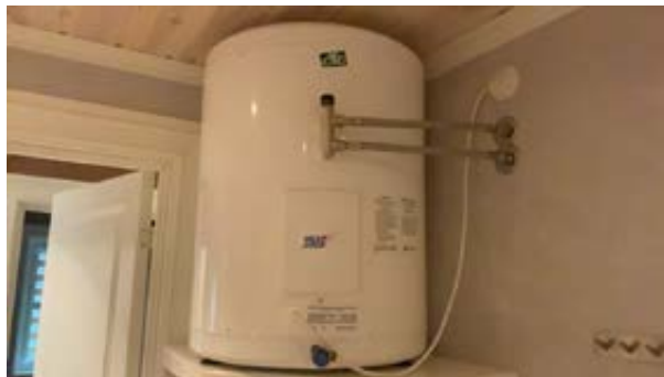
Varmtvannstanken er på 115 liter - CTC Heatingjection.
