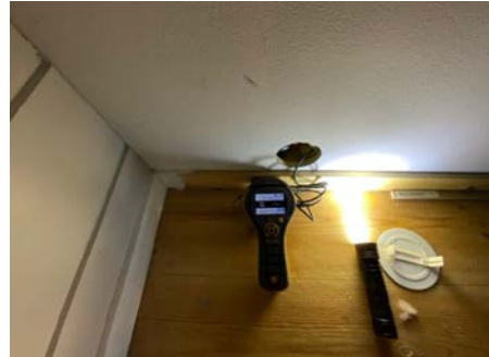
Fuktmåling, ingen fukt eller andre avvik registrert i borehull. Hull blir blendet forsvarlig.
