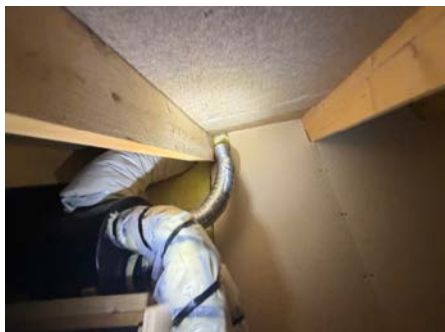
Uisolert ventilasjonskanal.
