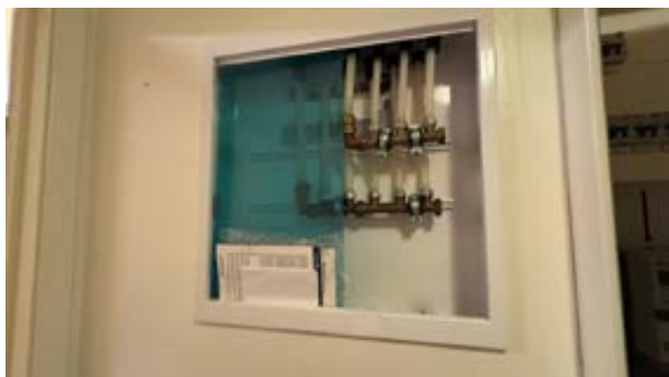
Mangler merking av vannledninger.
