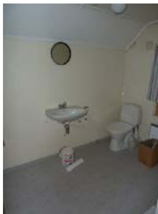
Toalett 3.etg. - ikke operativt
