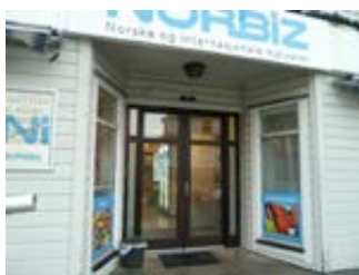
Hovedinngang forretning 1.etg. Rullestolrampe, hovedinngang.
