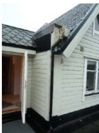
En rekke grater, arker, takopplett mot sør/øst
