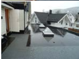
Flatt tak/takterrasse med overlys.
