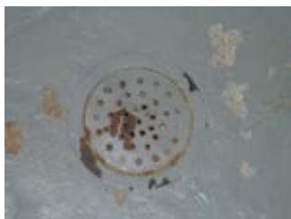
Eldre bunnledninger, sluk i u.etg.
