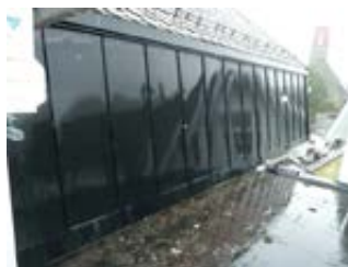
Båndteking og skifer på mansardtak.
