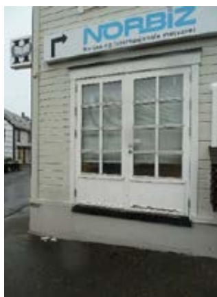
Biinngang 1.etg. mot øst. Kan brukes for inn-/utlasting, trapp/tilkomst mangler p.t. (høyde ca 0,5m over gate)
