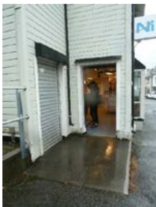
Varemottak (port) og heisport med rampe mot gaten-
