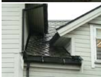
En rekke grater, arker, takopplett mot sør/øst
