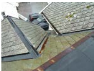
En rekke grater, arker, takopplett mot sør/øst
