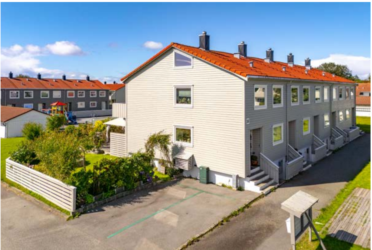
Yttervegger i tre med isolerglassvinduer fra 2022
