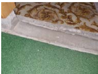
Betongsokkel ved alle vegger.
