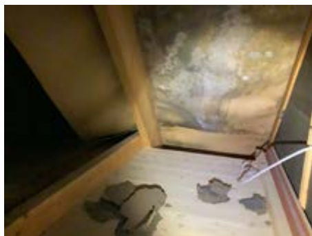
Fuktskadede undertaksplater mot øst
