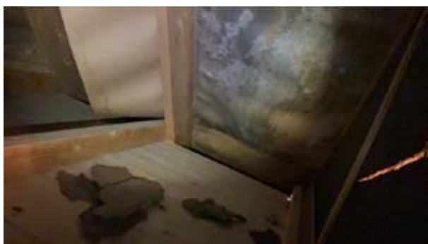
Fuktskadede undertaksplater mot øst
