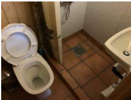
Oversikt bad i kjeller
