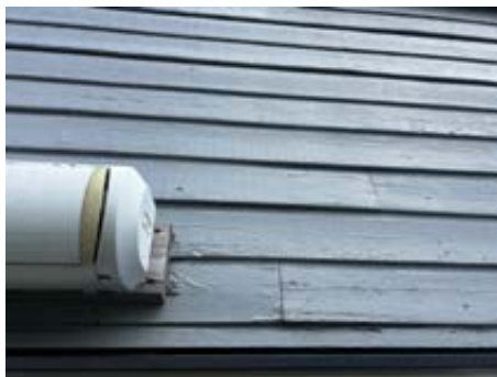
Fukt og råteskadet bordkledning.
