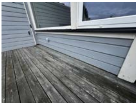
Fukt og råteskadet bordkledning.
