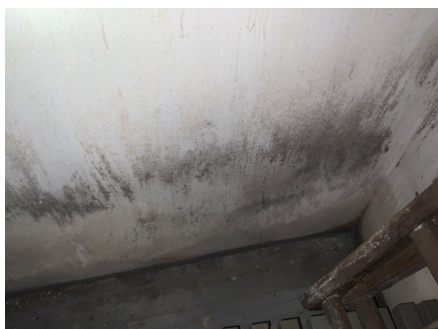
Råteskade på lettskillevegg
