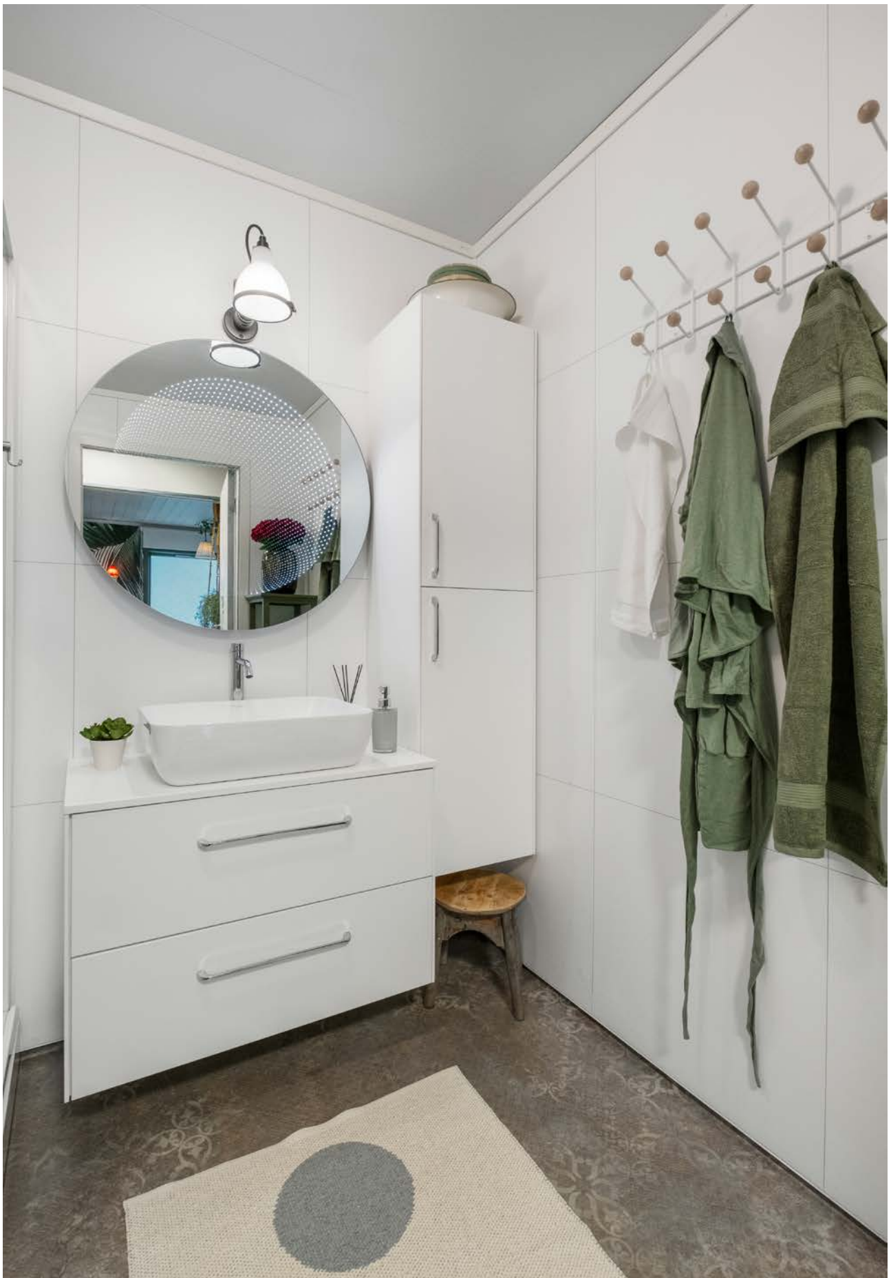
Veggene er kledd med baderomsplater, og himlingen har himlingsplater
