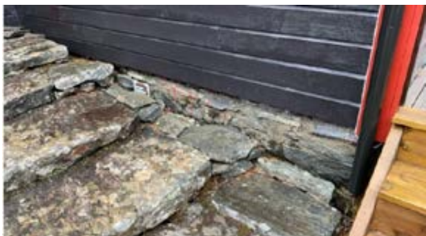
Visuelt synlig ventiler for krypkjeller uten tilkomst.
