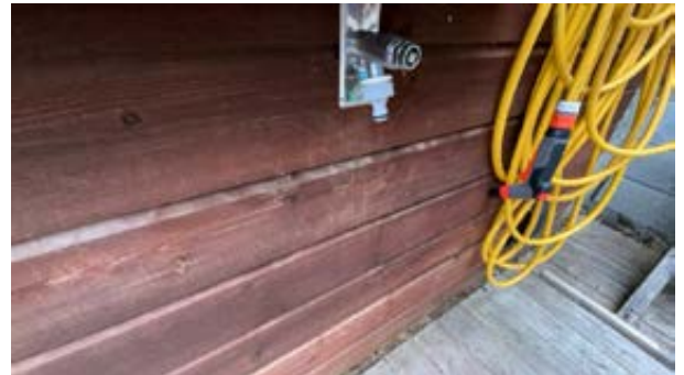
Utekrane mot øst.
