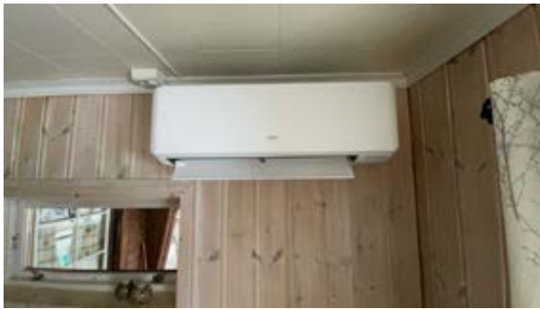
Innvendig varmepumpe.
