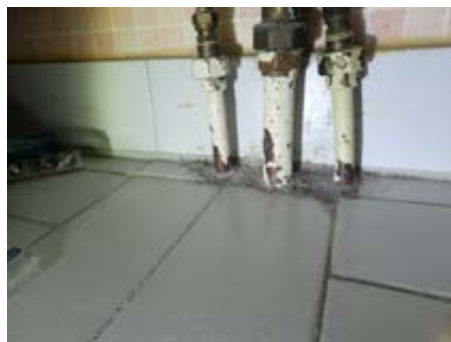
Utett rørgjennomføring
