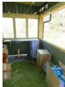
Overbygget altan/terrasse i 2.etg
