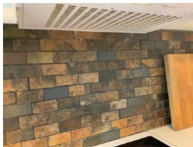
Flis på vegg over benkeplate.
