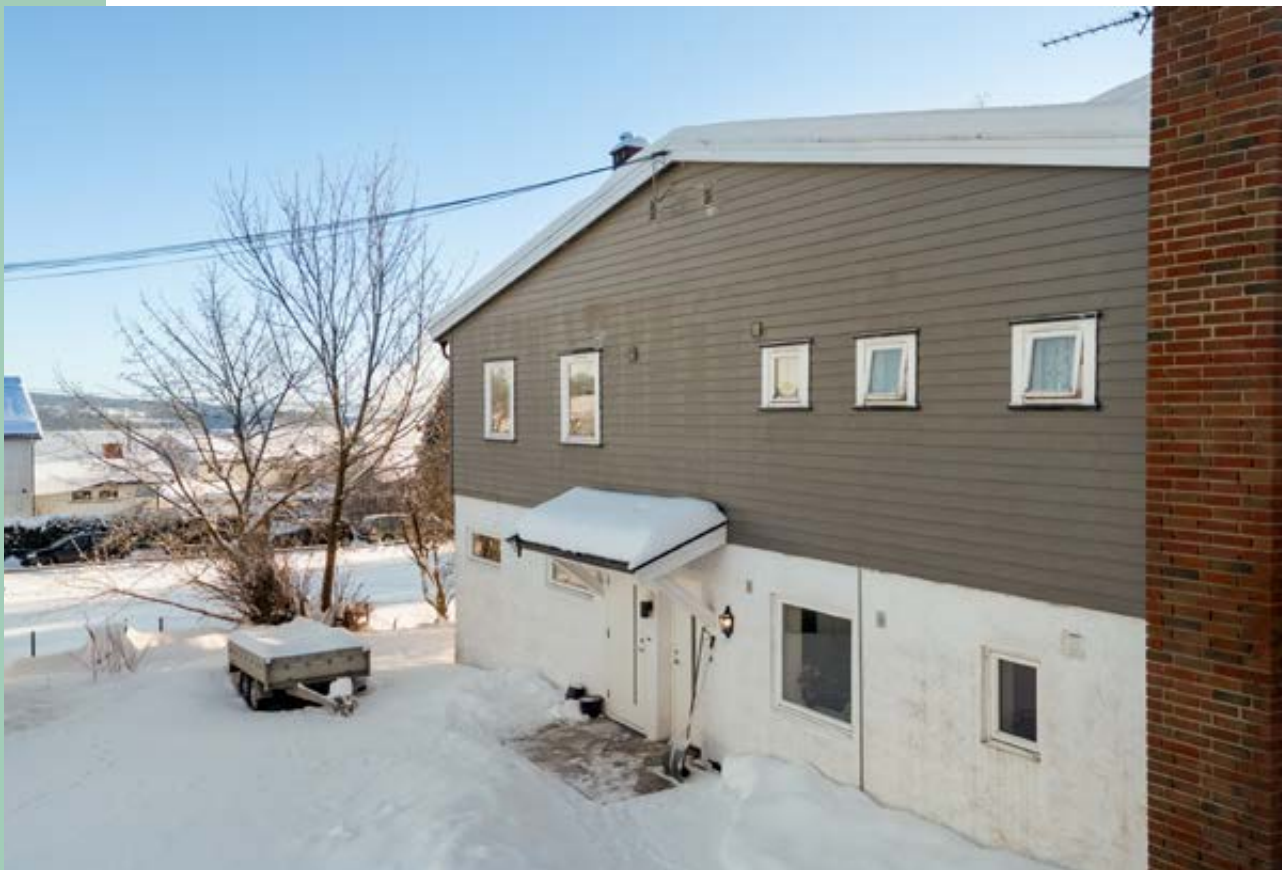
Bygningen har malte trevinduer med 2-lags glass og en malt hovedytterdør fra 2025, som gir god isolasjon og sikkerhet.
