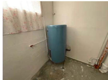
Varmtvannsbereder.
