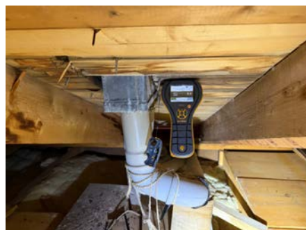
Fuktmåling, ikke utslag på fukt.
