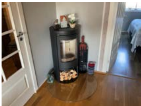
Vedovn med glassdør i stue.
