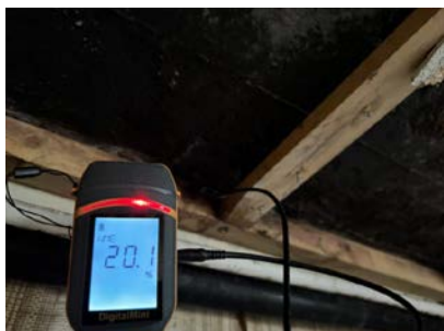
Kjeller, under inngang 1.etasje
