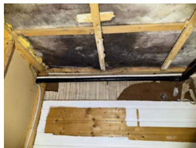
Kjeller, under inngang 1.etasje
