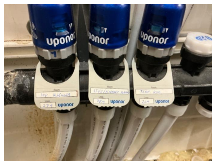
Lekasje fra kobling i rør i rør skap.
